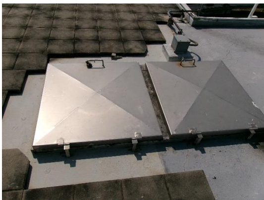
รูปที่ 3.1-4 ถังเก็บน้ำสำรองแบบ 2 ฝา
