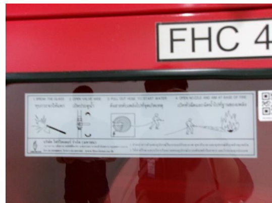
ตู้ดับเพลิง และป้ายคำแนะนำการใช้
