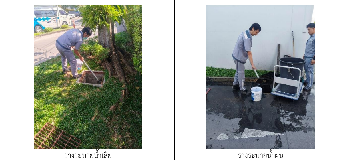
รูปที่ 3.3-2 การทำความสะอาดรางระบายน้ำ
