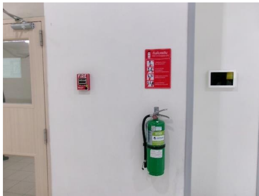
ถังดับเพลิง และป้ายคำแนะนำการใช้ถังดับเพลิง
