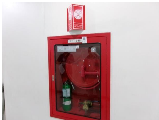
ตู้ดับเพลิง และป้ายคำแนะนำการใช้
