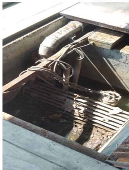
รูปที่ 3.3-4 ติดตั้งตะแกรงที่บ่อพักน้ำสุดท้าย ของจุดระบายน้ำ
